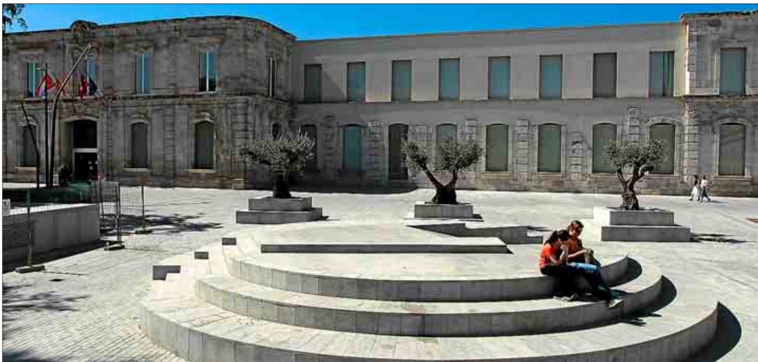
Estado en el que ha quedado el centro de la plaza de España de San Fernando tras la rehabilitación. A la izquierda, la Casa Consistorial. / ANTONIO HEREDIA
